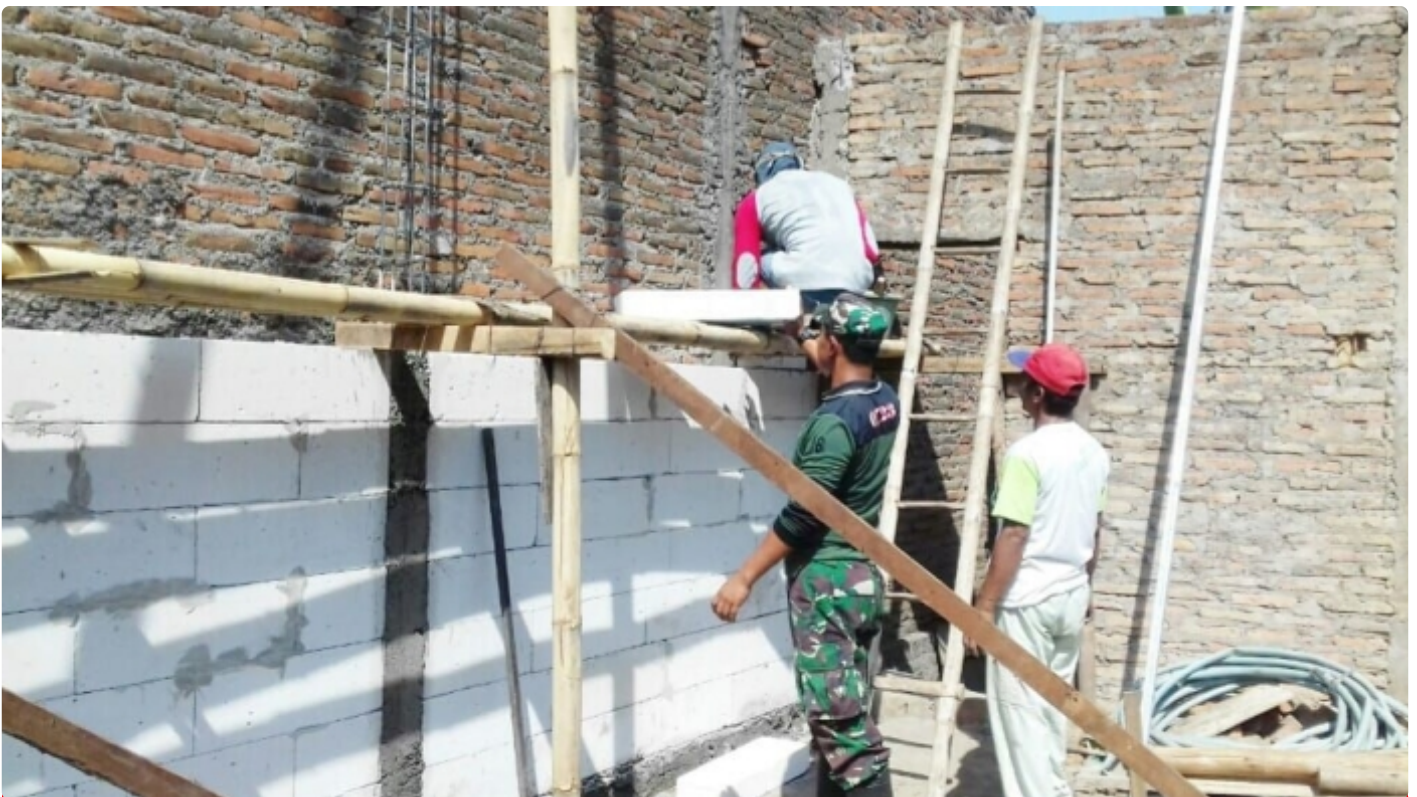
Babinsa Ceper Gotong Royong Bangun Rumah Warga Binaan
